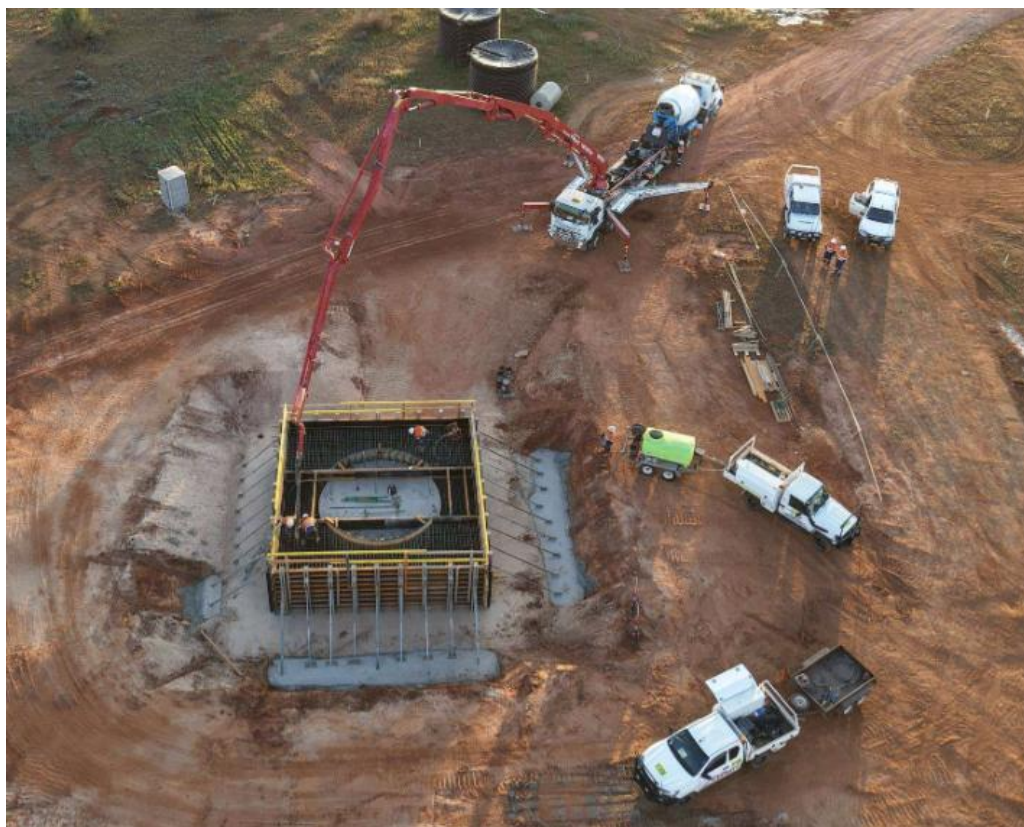
Photo: Concrete pour for the raisebore rig collar (September 2026)
