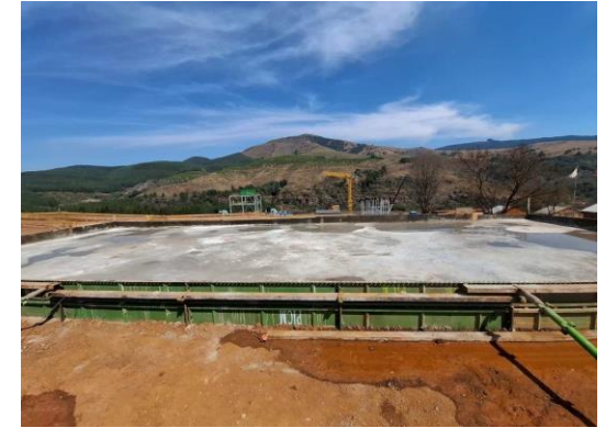
MCC 1 – pour and floating.
