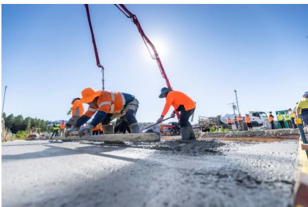
Figure 7: AusPozz™ Commercial-Scale Concrete Demonstration Pour
