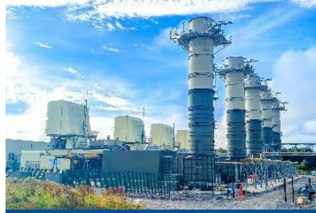
Bypass & HRSG Exhaust System
