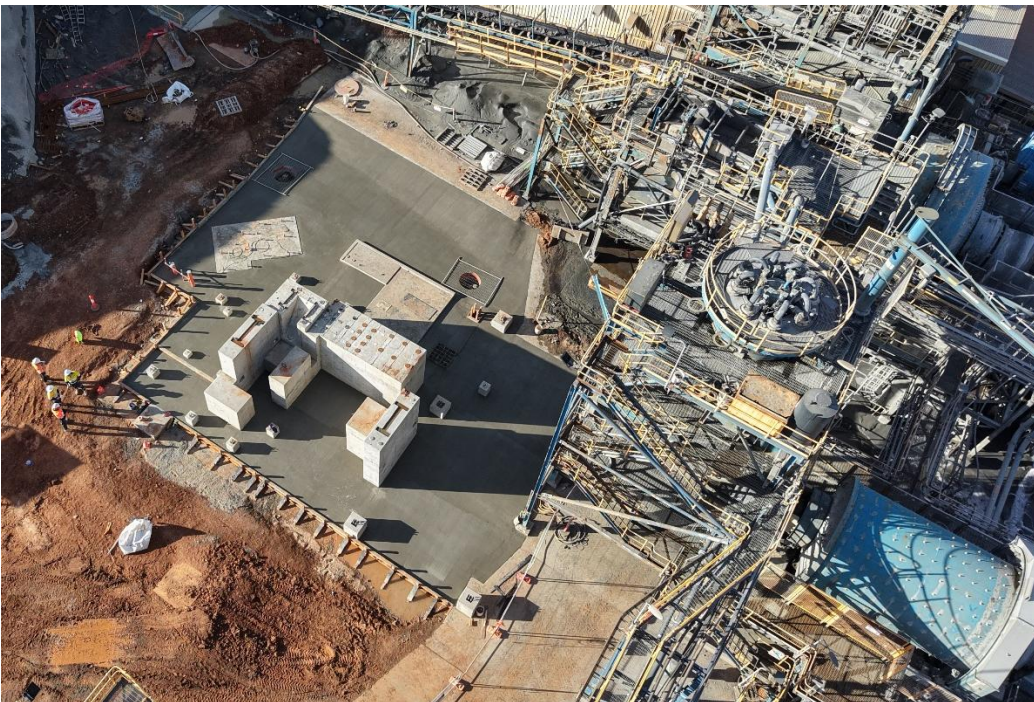
Photo: Concrete pour for the tertiary ball mill (July 2026)
