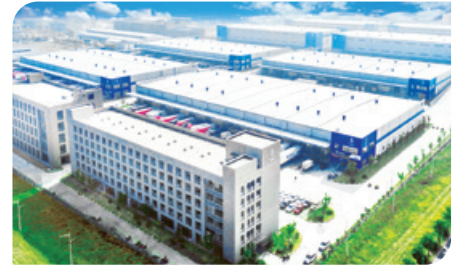
深國際物流港（杭州一期）
